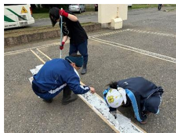
駐車場ライン引き作業
