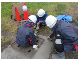
工業科：土木施工の様子
