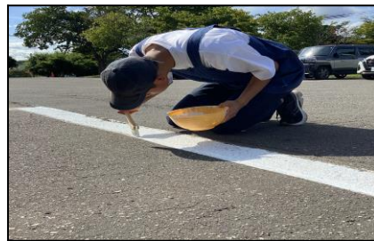
特設実習：駐車場のライン引き
