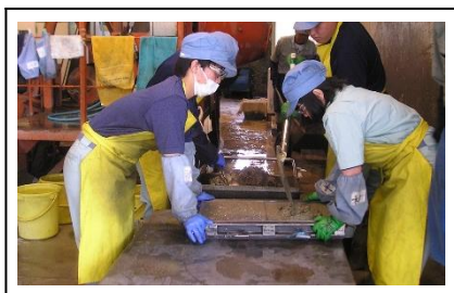
工業科：歩道平板づくり
