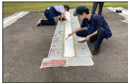
特設実習：駐車場のライン引き
