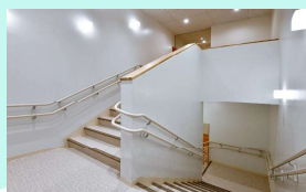
2階への階段 手すりは両側にあり、高さも2段階になっている
