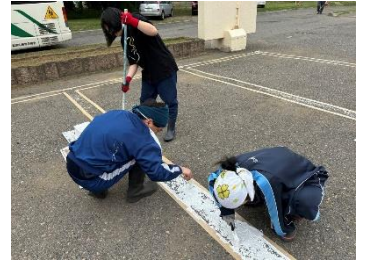
駐車場ライン引き作業
