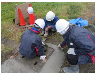
工業科：土木施工の様子
