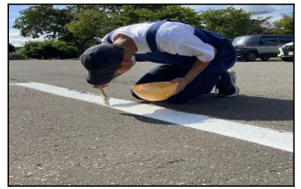
特設実習：駐車場のライン引き
