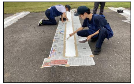
特設実習：駐車場のライン引き
