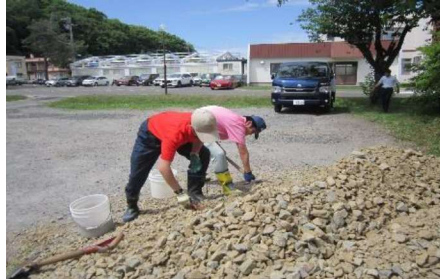
もなみワークス：駐車場整備
