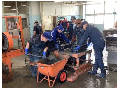
工業科：打ち込み
