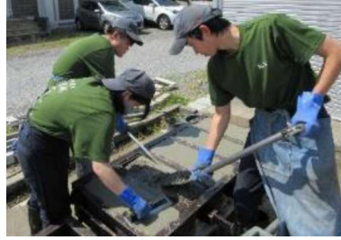
工業科：打ち込み
