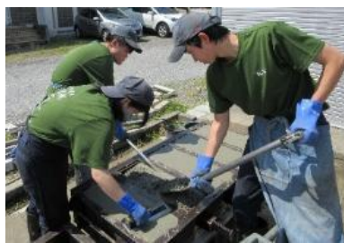
工業科：打ち込み
