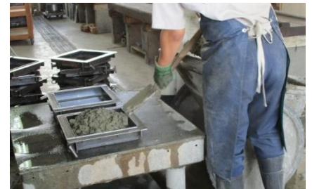
工業科：コンクリート作業
