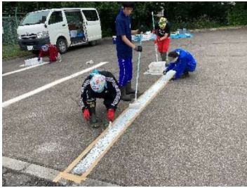
駐車場ライン引き作業
