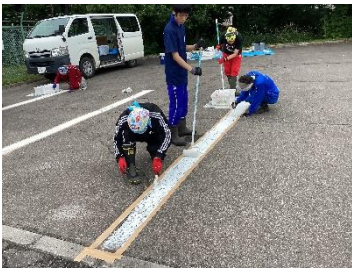
駐車場ライン引き作業
